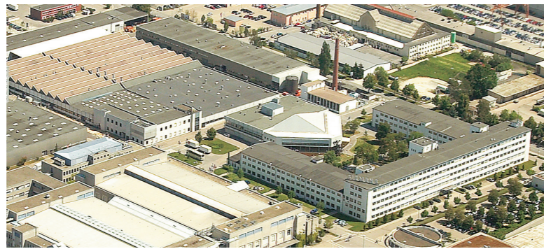
Fábrica de produtos de baixa tensão – Regensburg - Alemanha
